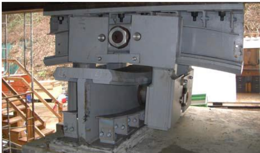
شکل ۵: جداگر آونگی اصطکاکی نواری با قابلیت تحمل نیروی کششی (کارول و همکاران)
