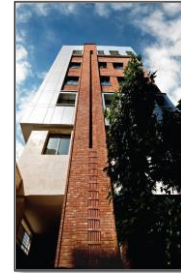
طراحی و اجرای معماری ساختمان اداری خیام
